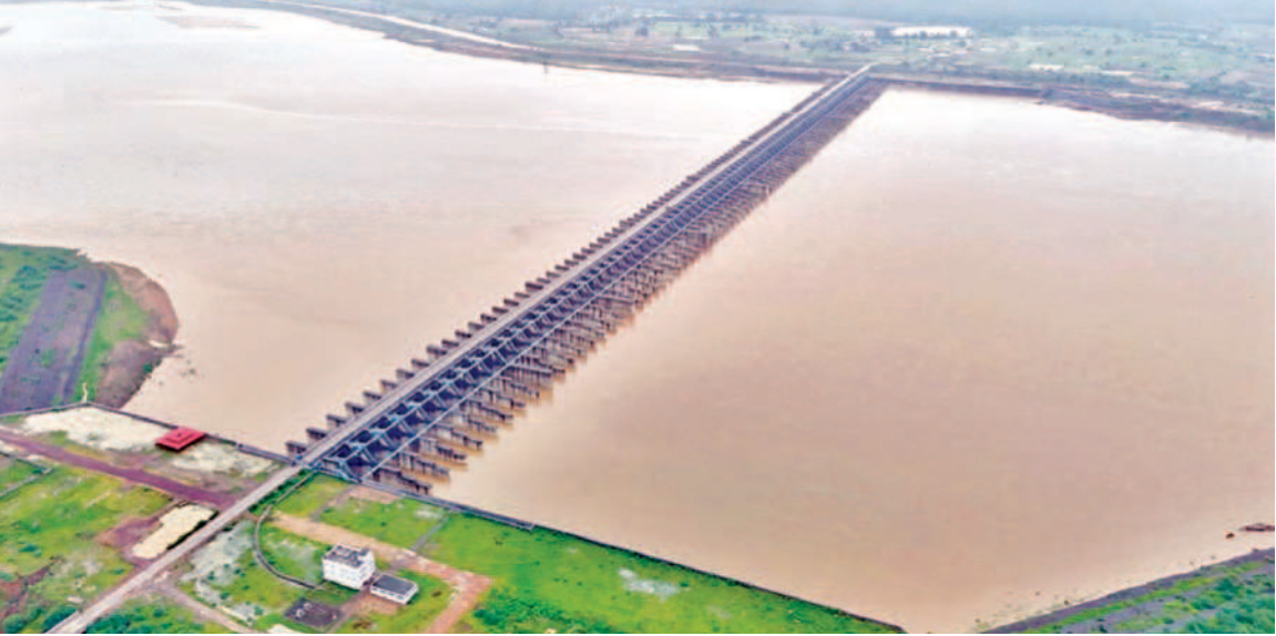
ఎడతెరిపిలేని వర్షాలతో మేడిగడ్డ ప్రాజెక్టులోకి భారీగా చేరిన వరద నీరు
